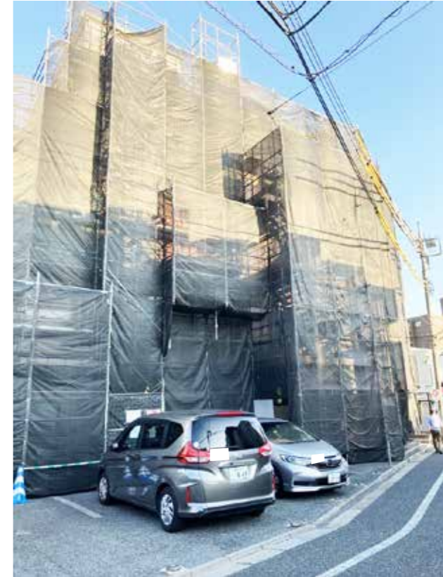
※東京練馬区の本社ビル修繕の様子（24年8月1日現在）
